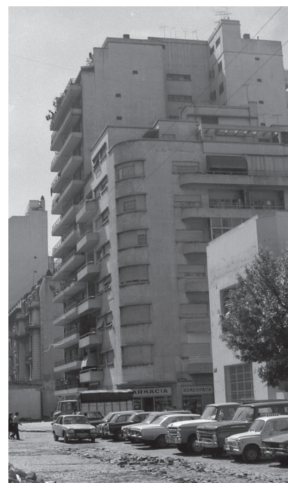
Antigua visual de la Av. San Juan.
