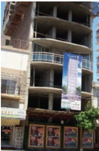
Edificio en construcción.
