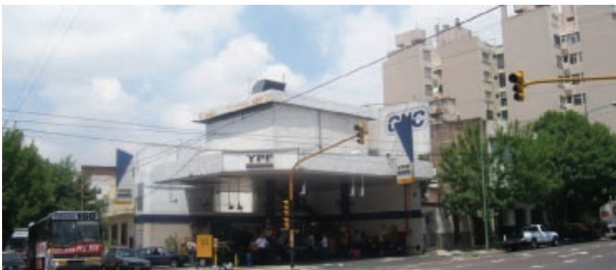
Estación de servicio en Av. Boedo.
